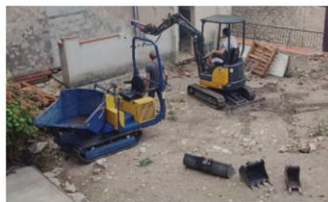
Rénovation du cours de la mairie. Travaux en cours © C. TEILLET
