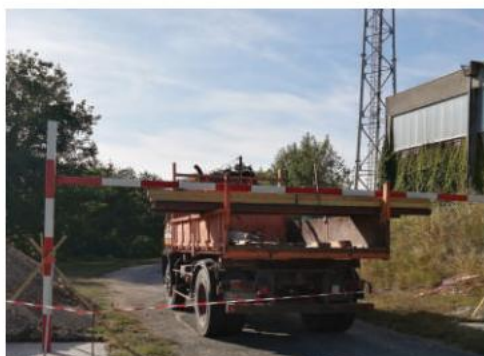
Installation en cours d'un portique au stade Coulon © L. DAROT
